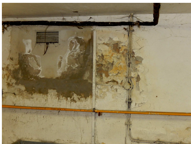
Obr. 31 Projevy zemní vlhkosti ve sklepním prostoru
