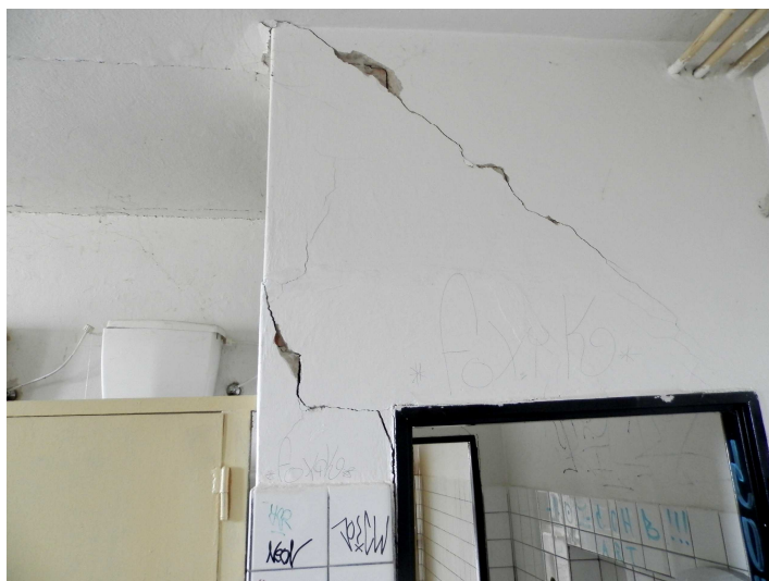
Obr. 49 Trhliny (v současnosti zatmelené)
