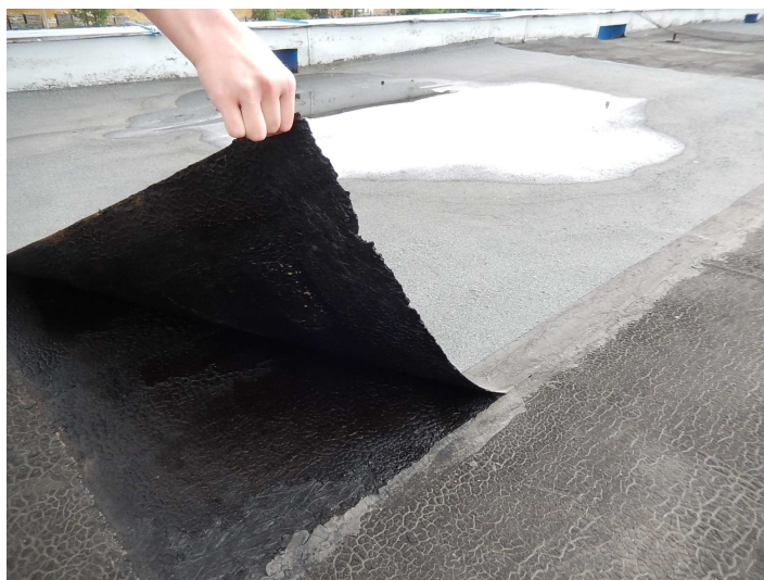
Obr. 26 Nekvalitně provedená oprava
