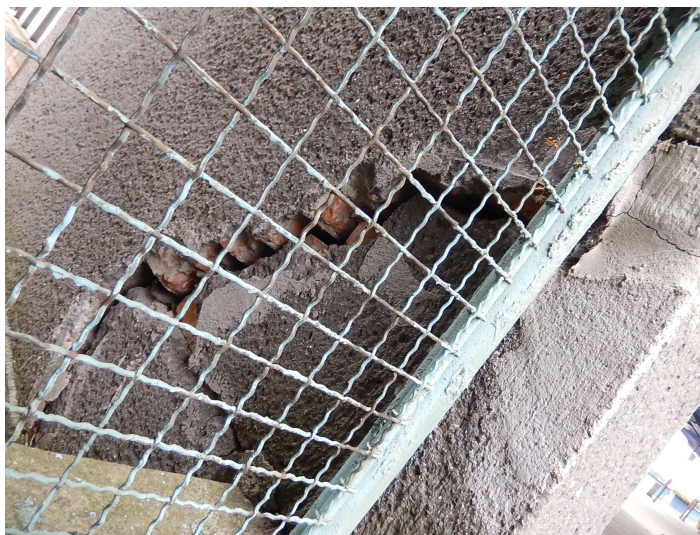
Obr. 64 Porucha nosného zdiva
