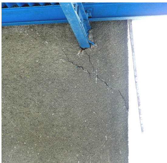
Obr. 65 Porucha v uložení přístřešku
