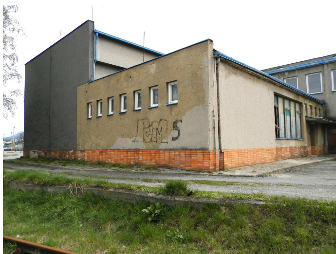
Obr. 39 Pohled na objekt (rozdílná barevnost soklu a fasády)
