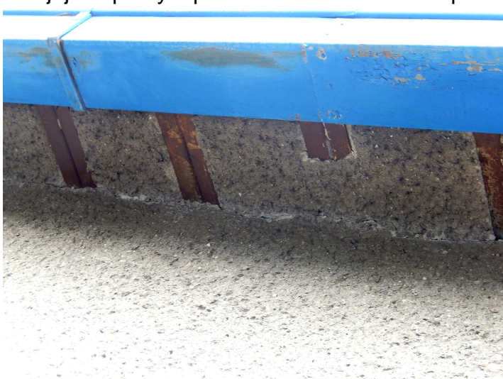
Obr. 13 Koroze nosníků střechy
