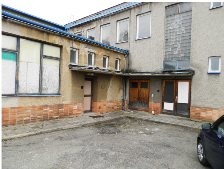
Obr. 19 Zatékání po fasádě (nefunkční okap)
