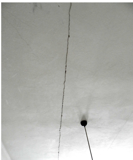
Obr. 17 Trhlina mezi PZD deskami
