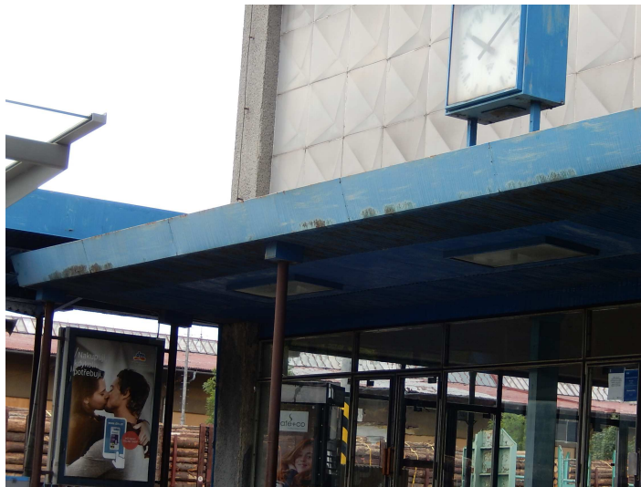
Obr. 14 Degradace přístřešku vstupu
