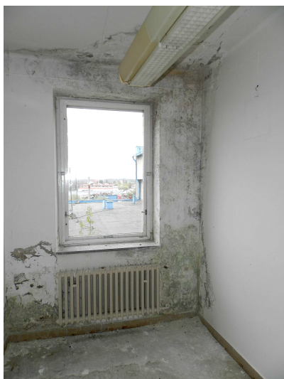
Obr. 23 Projevy zatékání
