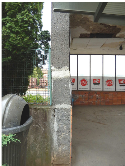
Obr. 63 Porucha nosného zdiva
