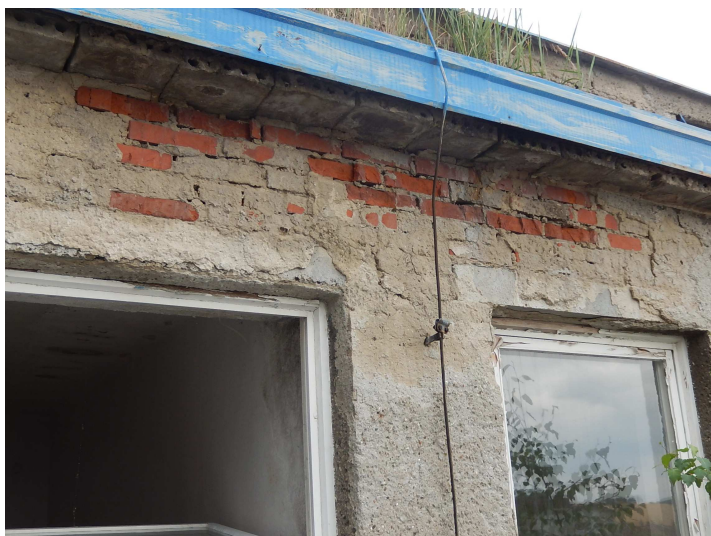
Obr. 27 Odpadávání zasolené omítky
