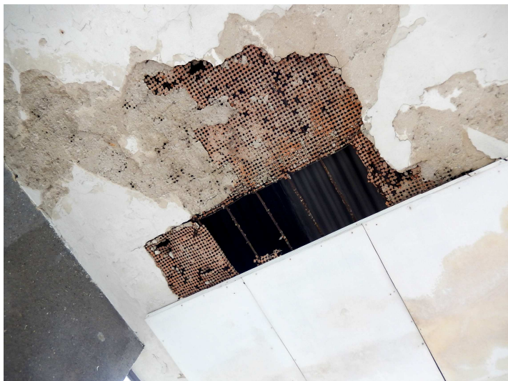
Obr. 61 Degradace a rozpad podhledu
