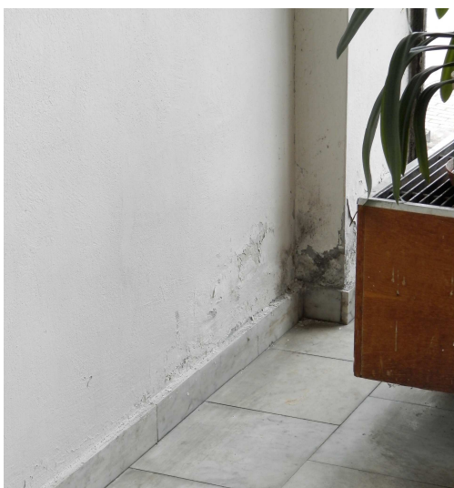
Obr. 9 Vztlínání vlhkosti
