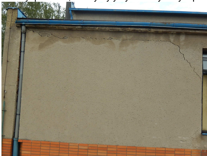
Obr. 42 Trhliny
