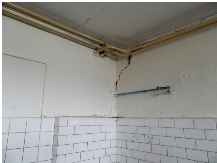
Obr. 45 Trhliny (v současnosti zatmelené)
