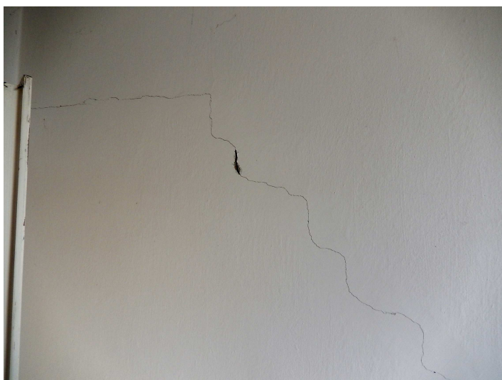
Obr. 35 Trhliny v příčce
