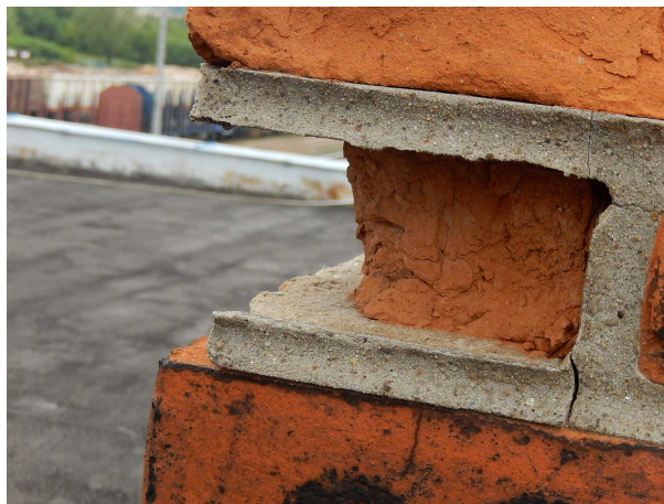
Obr. 38 Rozpad komínových těles
