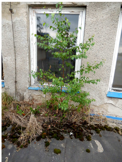
Obr. 56 Vegetace na střeše jednopodlažní části
