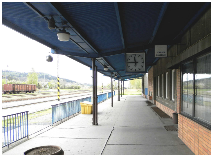
Obr. 57 Přístřešek (rámy tvaru V)
