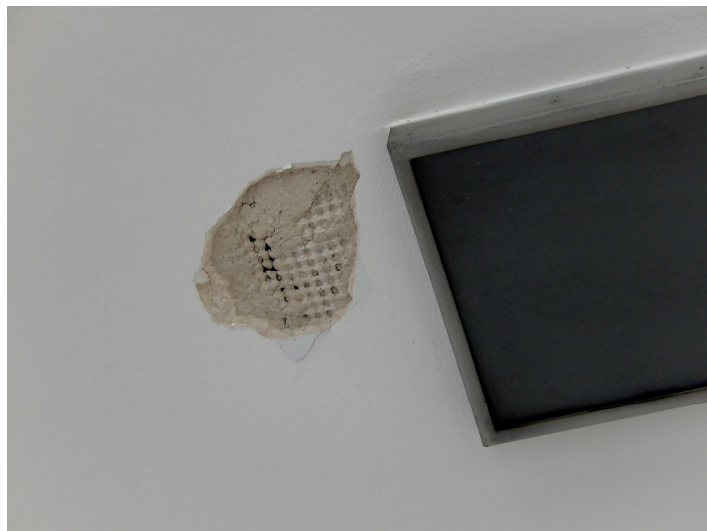
Obr. 16 Odpadávání omítky podhledu
