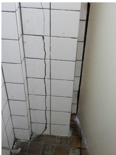
Obr. 48 Trhliny
