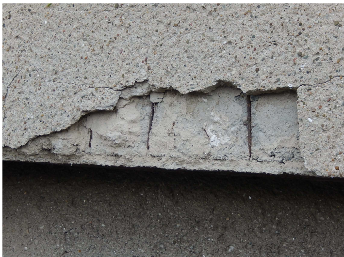
Obr. 11 Koroze výztuže
