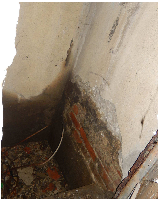
Obr. 33 Vlhkost ve sklepním prostoru
