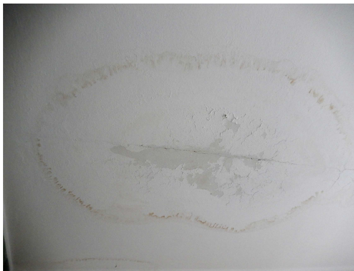
Obr. 18 Trhlina mezi PZD deskami + zatékání vody
