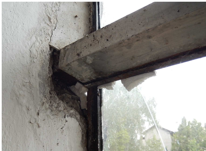
Obr. 7 Vytržení nosníku opláštění
