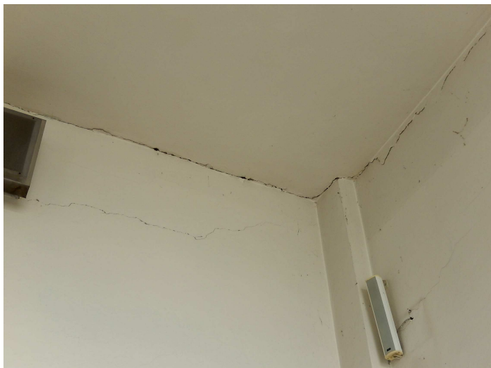
Obr. 15 Trhlina na rozhraní střeška/stěna
