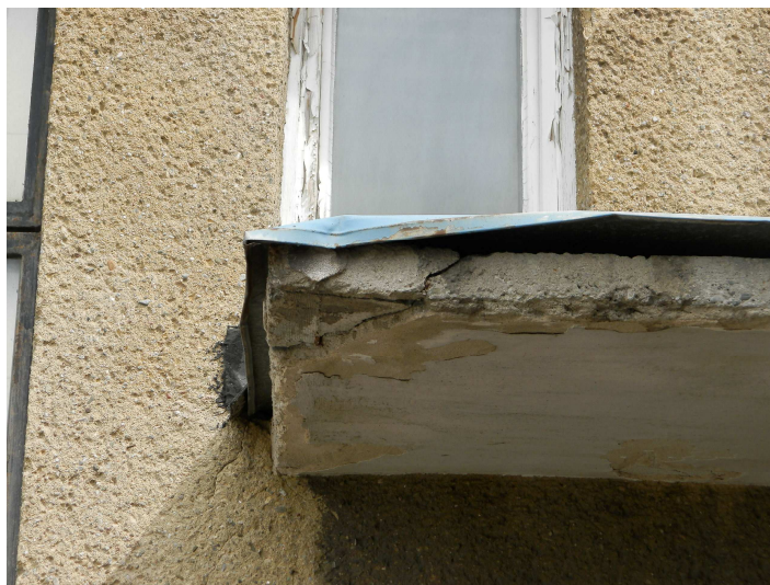
Obr. 55 Koroze výztuže a destrukce ŽB. stříšky
