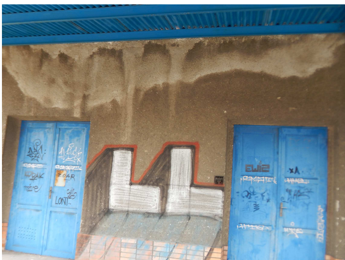
Obr. 59 Degradace fasády skladu
