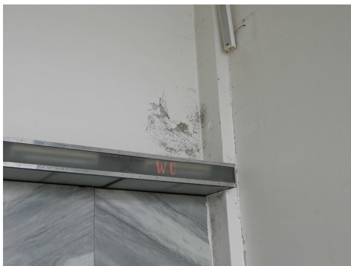
Obr. 10 Vlhkostní projevy v návaznosti na objekt WC
