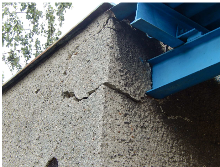
Obr. 66 Porucha v uložení přístřešku
