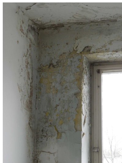
Obr. 30 Projevy zatékání
