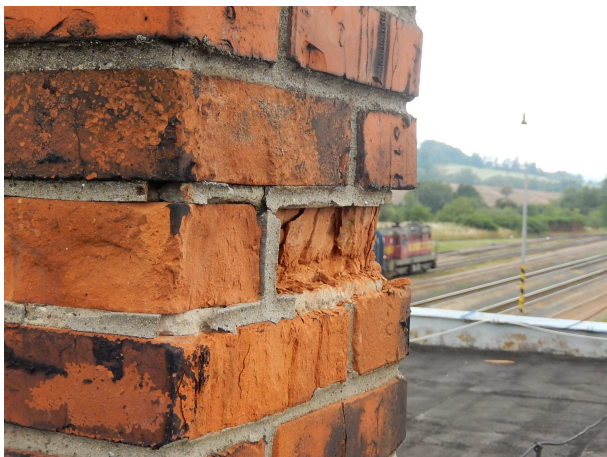
Obr. 37 Rozpad komínových těles
