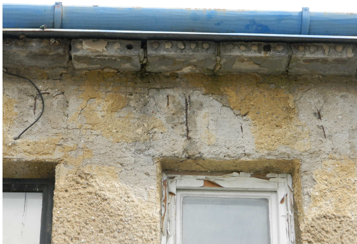
Obr. 54 Koroze výztuže
