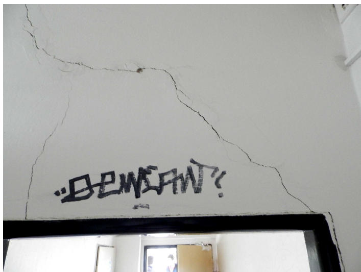
Obr. 47 Trhliny (v současnosti zatmelené)
