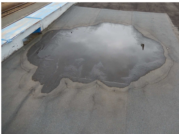
Obr. 25 Špatné spádování střechy
