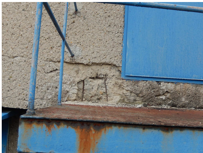
Obr. 12 Koroze výztuže + koroze OK plošiny
