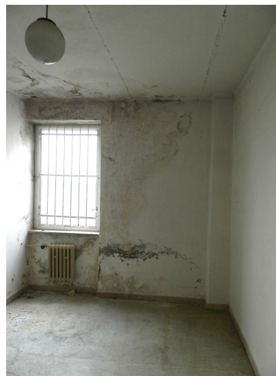
Obr. 20 Projevy zatékání
