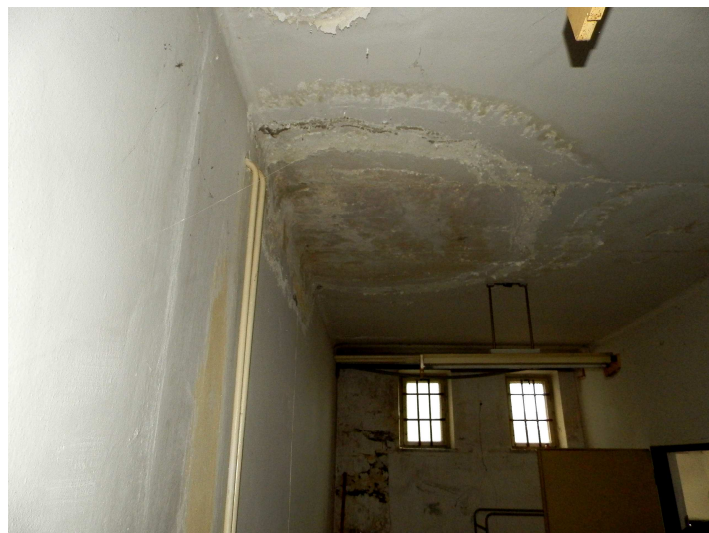
Obr. 51 Projevy zatékání
