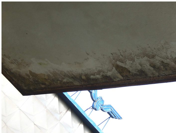
Obr. 62 Degradace podhledu
