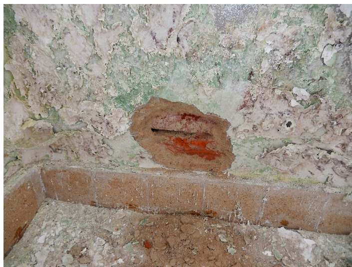
Obr. 28 Sonda do zasolené omítky
