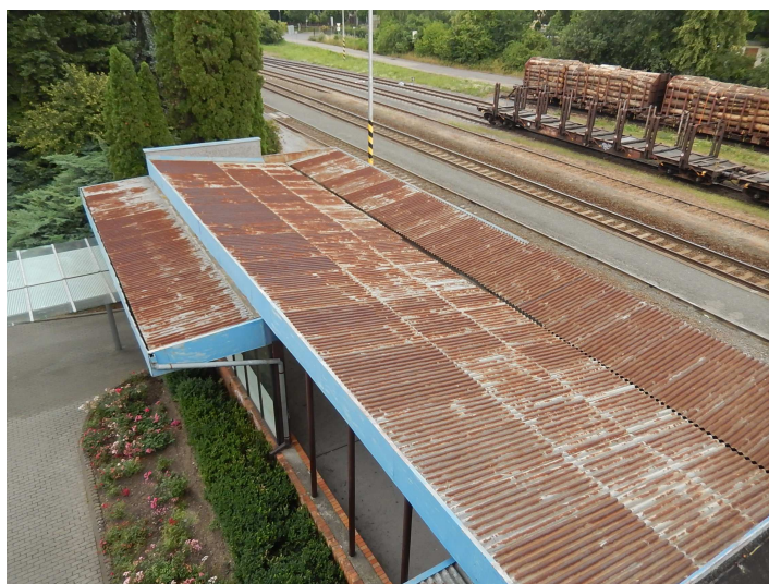
Obr. 60 Plošná koroze vlnitých plechů
